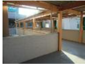
平成24年度末に建設した増築校舎への2階通路
