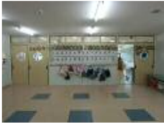
平成23年度末に改造化工事をした教室(4教室あり)を廊下から見る
