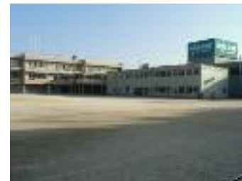
校庭から、増築校舎と本校舎を見る
