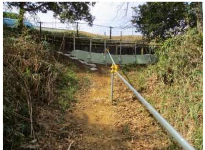
**左の写真は《土のう(白い袋に土を入れたもの)》をならべて、道幅を倍にし終えたところです。しかし、土のうを並べるだけでは崩れてしまうため、右の写真のように土止め専用の金属板をしっかり立て、土のうを隙間なく並べていったのです。急な所には手すりをつけ、歩くきやすく階段もつけました。**
